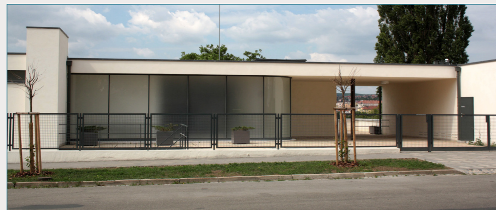
Průčelí z ulice [VT1]
