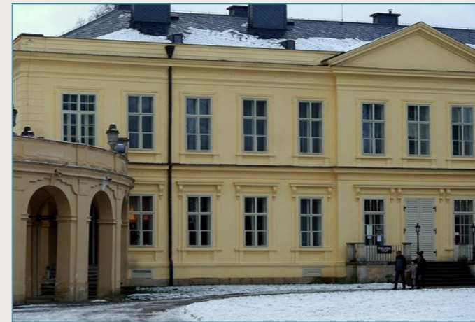
Bývalá správní budova (čp. 38) z počátku 19. stol. na západním konci arkádové galerie [PL4]
