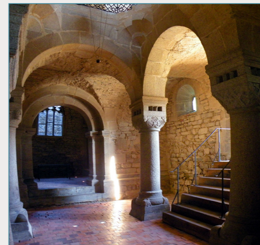
Dolní kaple [CH4]
