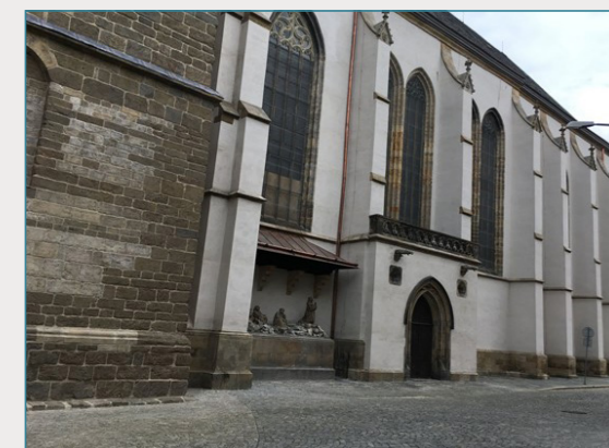
Jižní strana se sousoším Olivetské hory [MO1]
