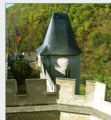
Studniční věž [KA10]
