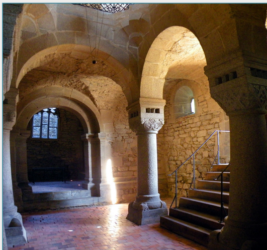
Dolní kaple [CH4]
