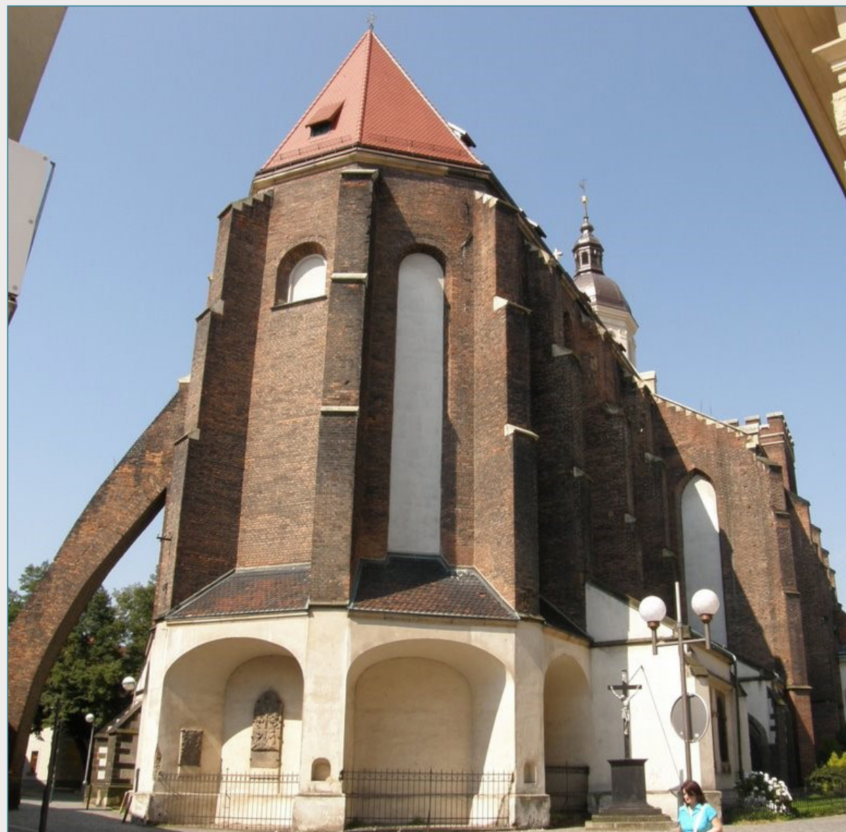
Pohled od východu s dochovaným jižním opěrným pilířem [KN6]
