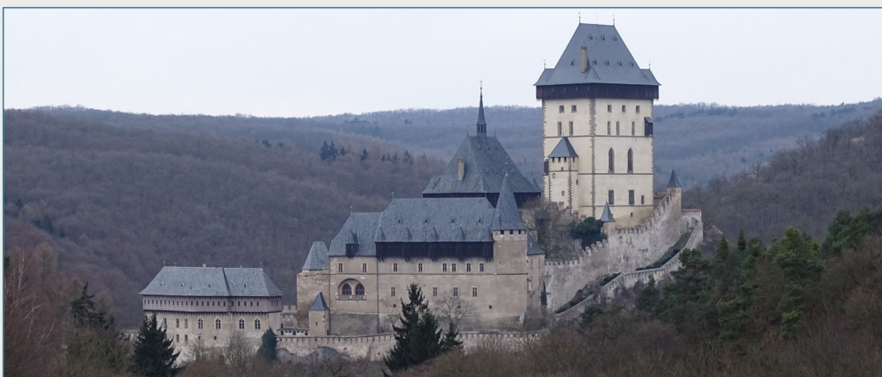
Pohled na Karlštejn od jihovýchodu ze sedla mezi Plešivcem a Haknovou. Vlevo studniční věž, uprostřed purkrabství, vpravo císařský palác, za ním Mariánská a Velká věž [KA8]
