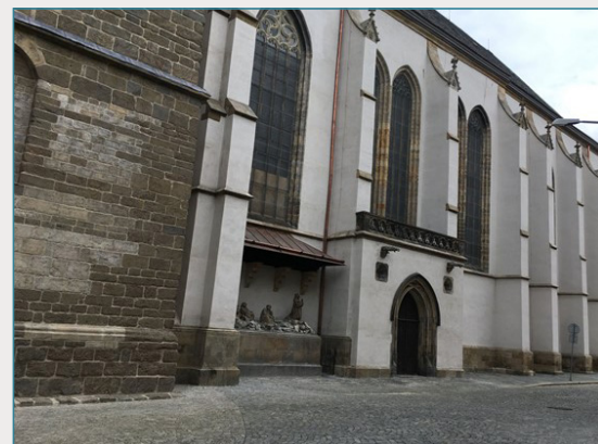
Jižní strana se sousoším Olivetské hory [MO1]
