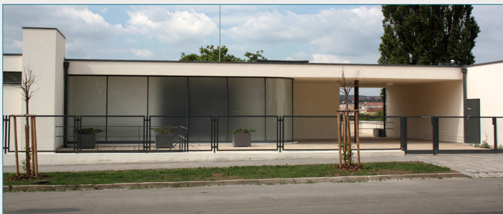
Průčelí z ulice [VT1]
