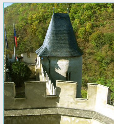
Studniční věž [KA10]
