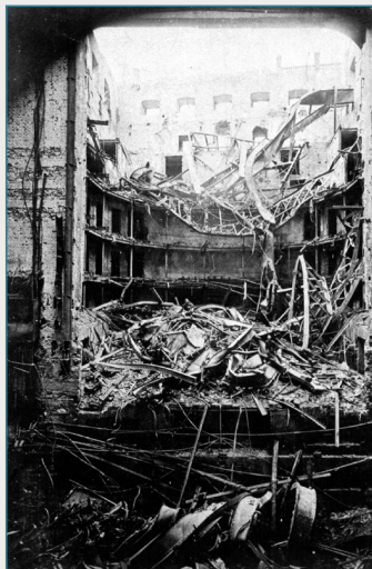
Vnitřek divadla po požáru [ND5]
